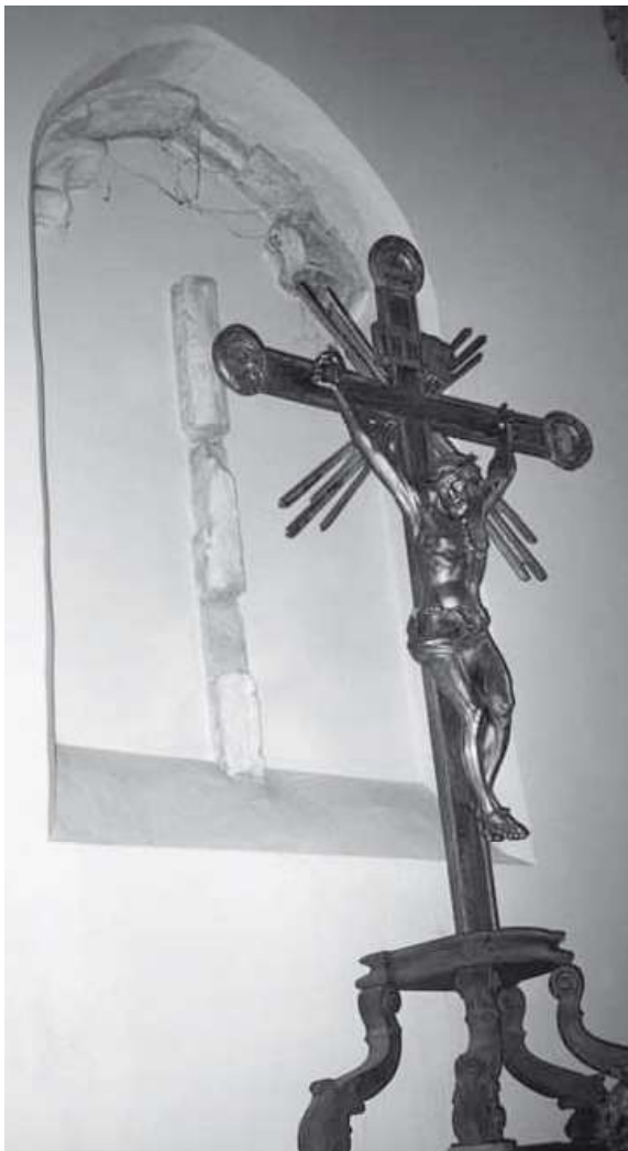
Afb. 7. Dichtgezet raam in Oostwand zijbeuk.
