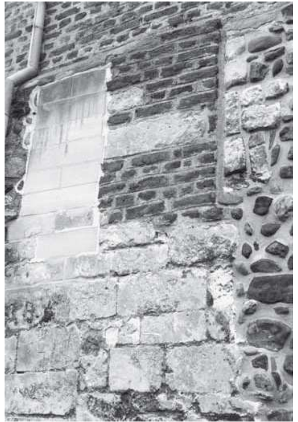
Afb. 11. Dichtgezet raam in de noordmuur.
