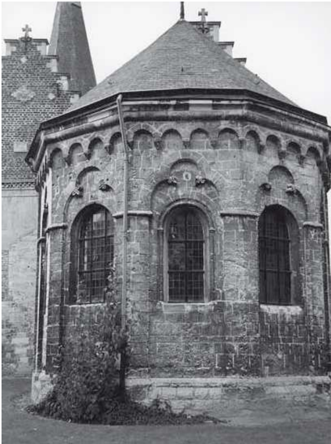
Afb. 1. De absis van de buitenzijde. Goed te zien is de verzorgde uitvoering in regelmatige gekapte mergelblokken en de rijke versiering zowel aan de bovenzijde als om de ramen. Het middelste heeft de extra versiering met zuiltjes waardoor het smaller is.
