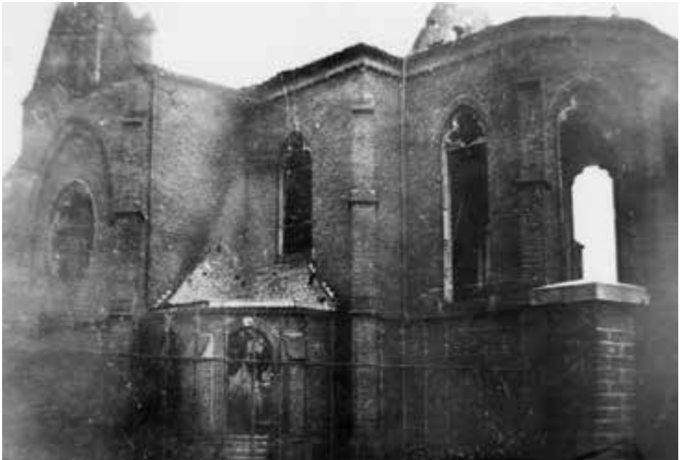
Uitgebrande kapel van het zusterklooster in de Geenstraat
