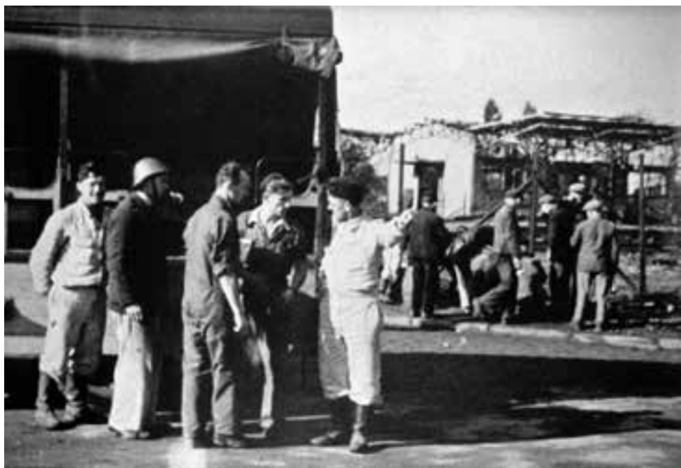
Puinopruiming hoek Groenstraat en Min. Ruysstraat
