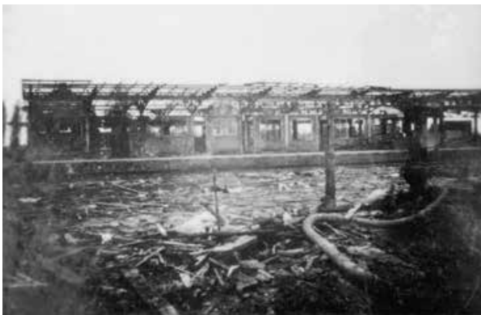
Puinruimen op station Lutterade
