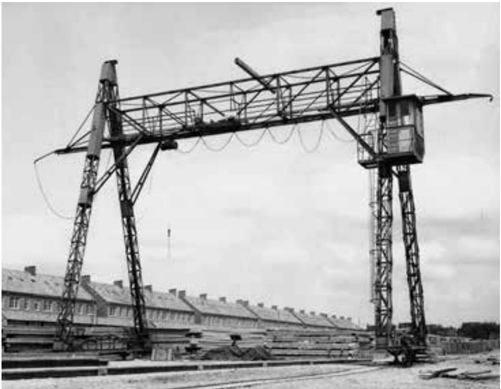
Bouwkraan in gebruik bij de bouw van de huizen van de Eloystraat
