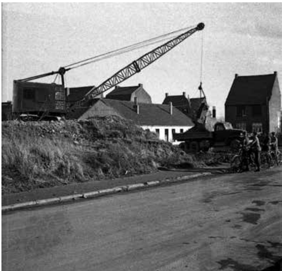
Werkzaamheden op puinhoop Groenstraat. Bestemming puin t.b.v. grondlaag Eloystraat
