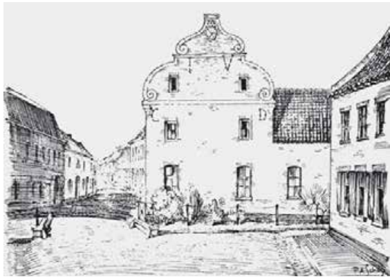
Aan de "Dörpsbrök", in het centrum van Oud-Geleen, in 1916. Van rechts komt de Keutelbeek uit de Hoog Steeg, stroomt langs het tuintje van het huis uit 1753 - met de initialen IV [= Jan Vroemen] en CD [= Catharina Dullens] - en onder de brug door naar de dorpspoel. Het huis geheel rechts, waar de gezusters Smeets woonden, werd bij de verbreding en ophoging van de Hoog Steeg [tot Pastoor Vonckenstraat] in de jaren twintig afgebroken <Tekening door P.A. Schols>.
